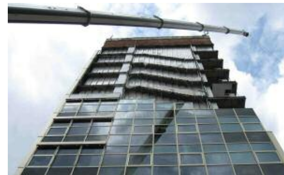
MFF – rekonstrukce fasády katedrového objektu v Troji
